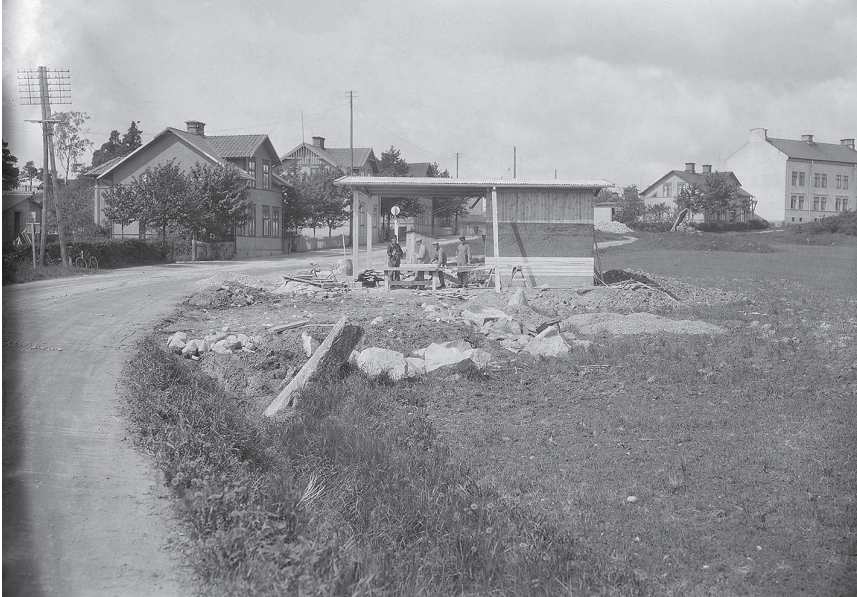
Fig. 5. Runstenarna vid Gredby gata utanför Eskilstuna i juni 1929. I diket framför den påbörjade bensinstationen halvligger runstenen Sö 107. Den mer än 3 meter höga Sö 109 ses i en liknande position framför trävillan i bakgrunden till höger. Foto H. Faith-Ell 1929.
